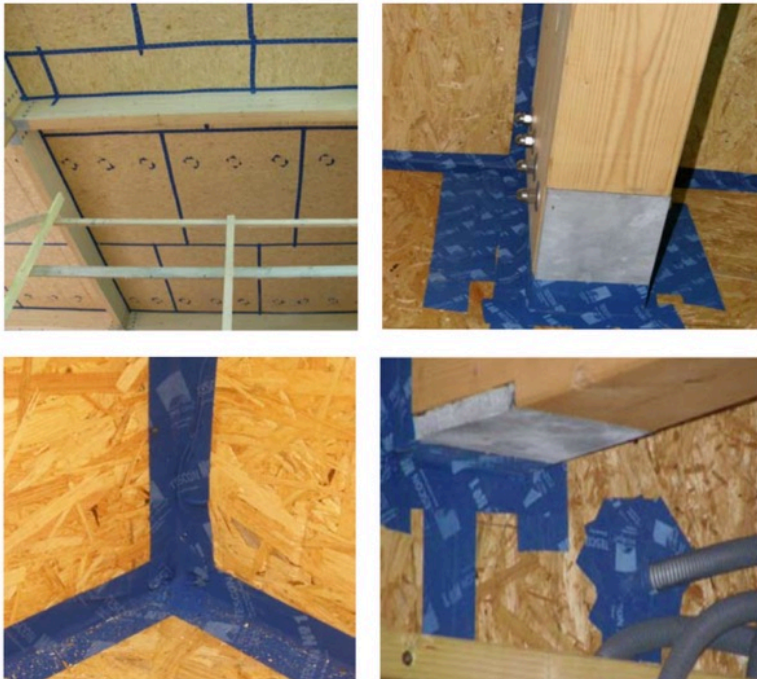
Source énergie positive
